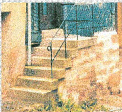
Außentreppe mit Bruchsteinunterbau und Geländer aus Schmiedeeisen
