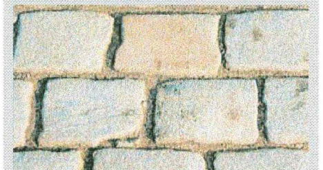
Reihenpflaster: eine Reihe hellgrauer Granitsteine trennt die Teilstücke aus anderen Gesteinsarten
