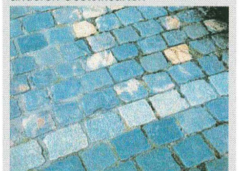
Reihenpflaster: eine Reihe hellgrauer Granitsteine trennt die Teilstücke aus anderen Gesteinsarten
